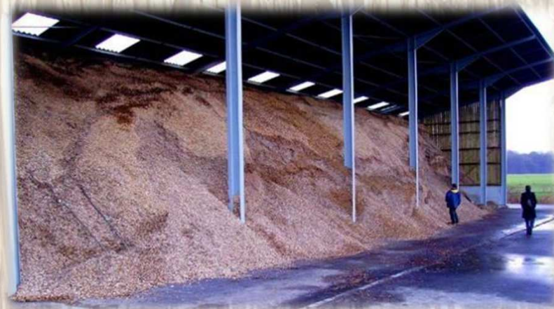
Bâtiment de stockage
